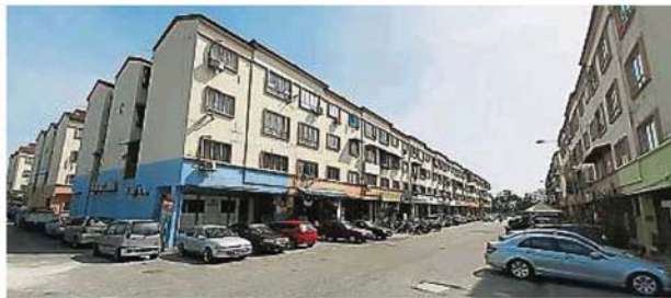
外劳租户居多，屋主对缴付管理费反应欠佳，使联合管理机构面对经费不足，未能及早处理停车场积水问题。
