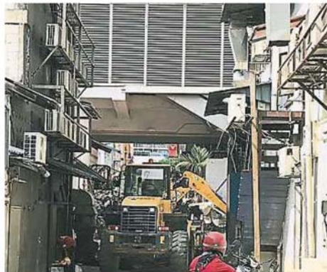
吉隆坡市政局出动铲泥机，拆除霸占十五碑淡比必拉路后巷的违建扩建结构。
